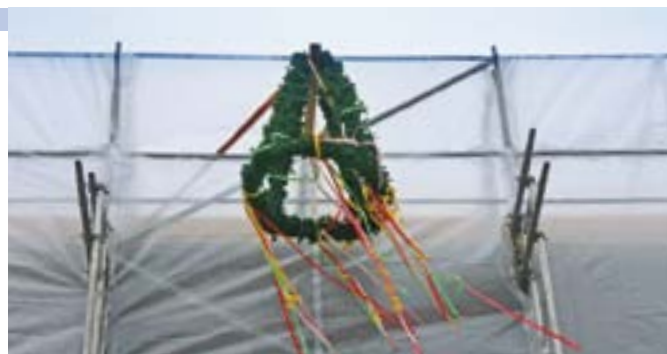
Richtfest an der neuen Mensa. Eröffnung noch in diesem Jahr!
