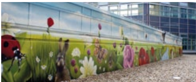
Farbenfrohe gestalteter Lüftungsschacht der IMC 1
