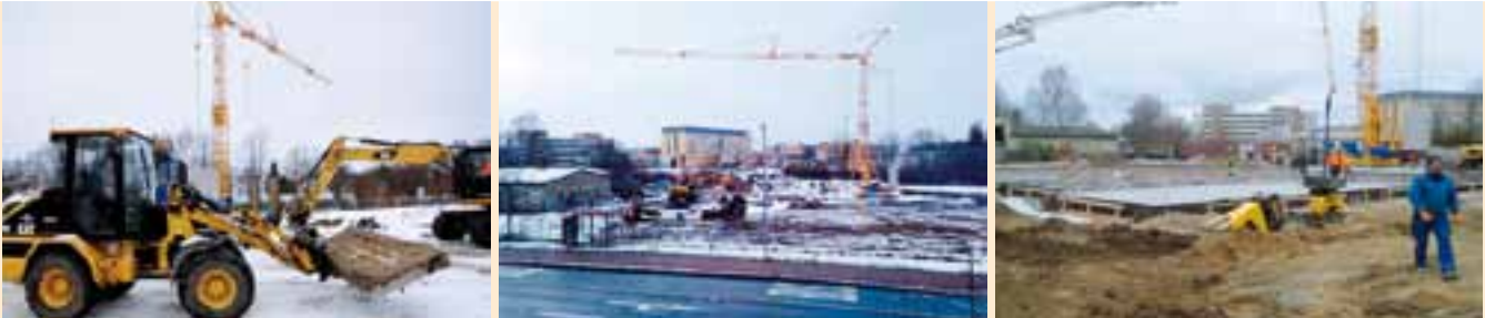
Die Bauarbeiten für das neue Firmengebäude sind in vollem Gange.
