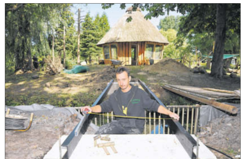
Torsten Ladwig, Mitarbeiter im Tierpark, bei der Montage der Brücke, die auf die Affeninsel führen wird. Foto: Peter Binder
