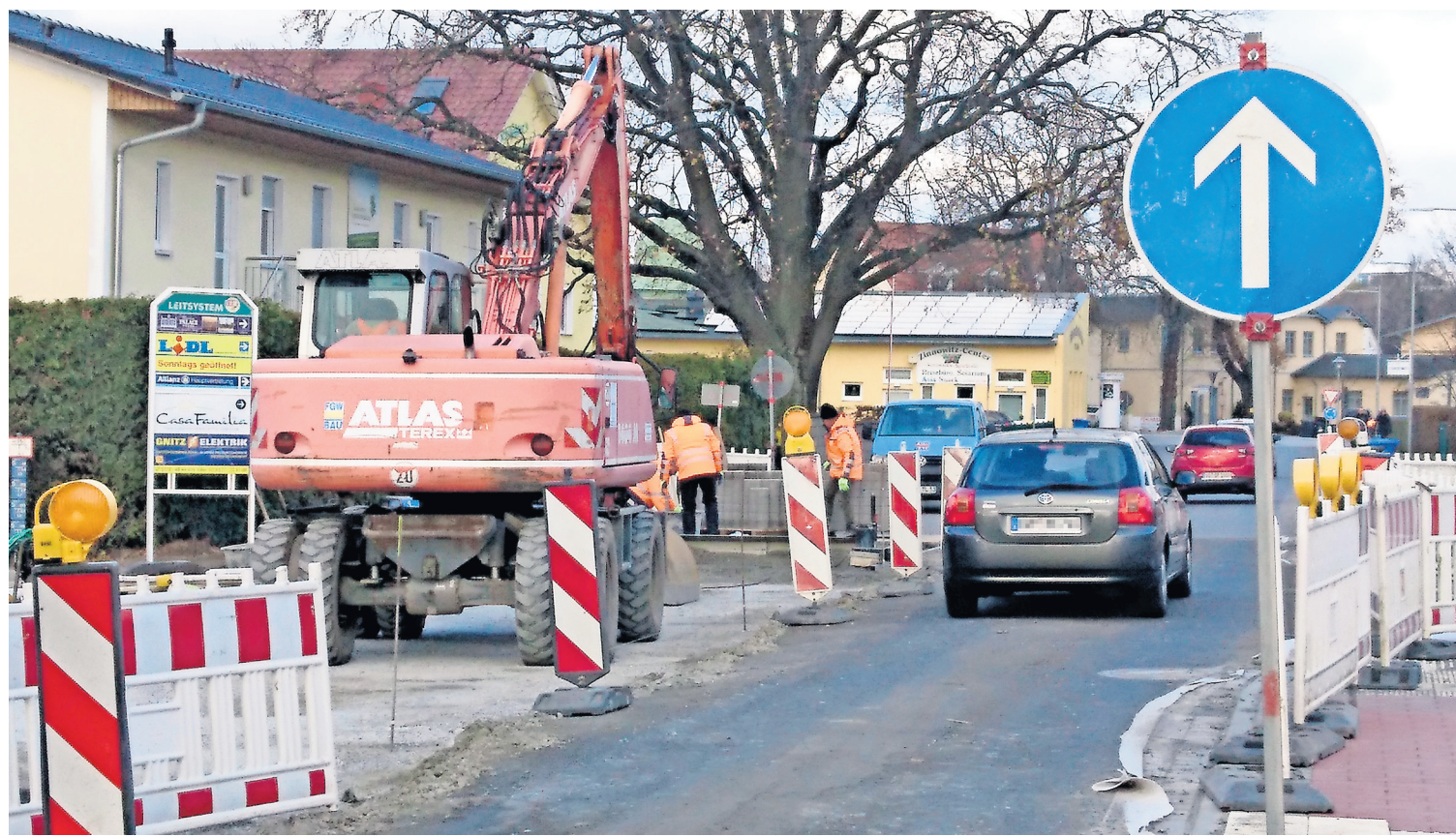
Im Zinnowitzer Möskeweg steht der erste Bauabschnitt kurz vor der Fertigstellung.
